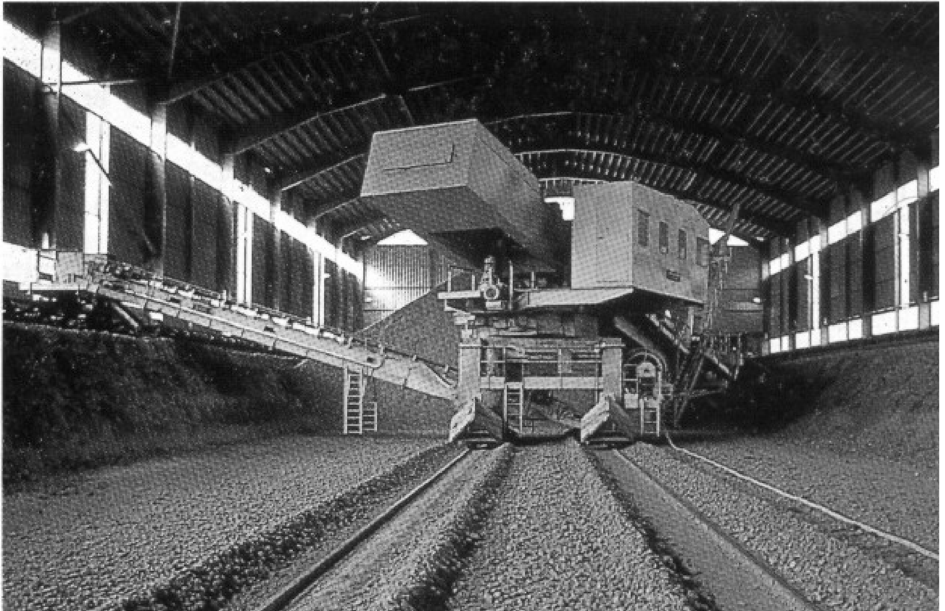
Hall de Préhomogénéisation
