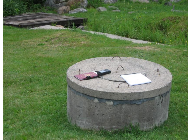
Puits de surface
