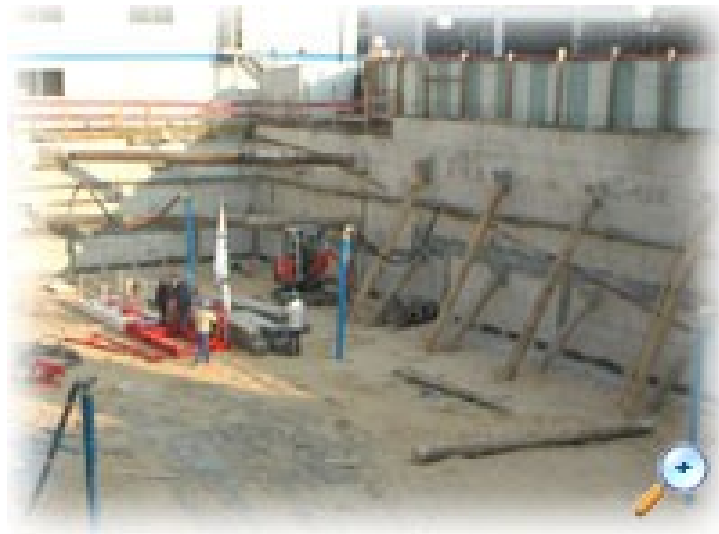
Rabattement de nappes par puits filtrants.
