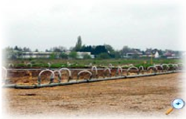
Rabattement de nappes par pointes filtrantes.
