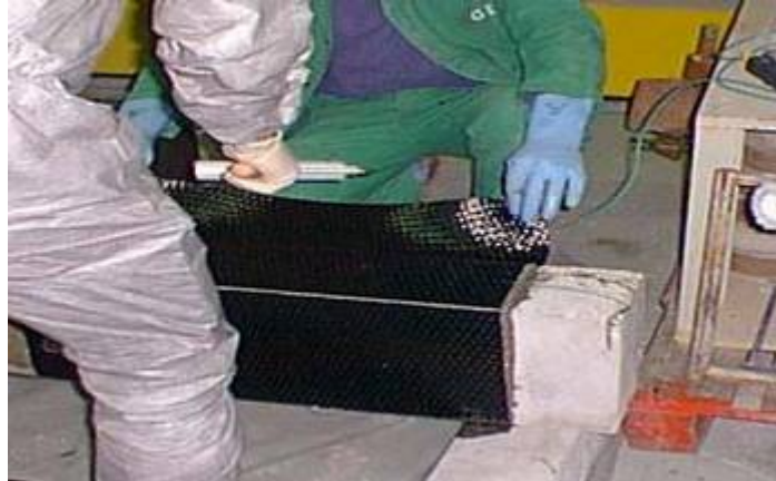
(5) Mise en place, sans étirement, du tissu sur le support béton.
