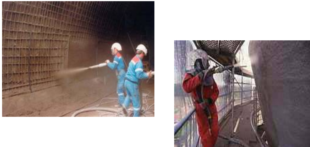
Figure 3.2 : Renforcement au moyen de béton projeté
