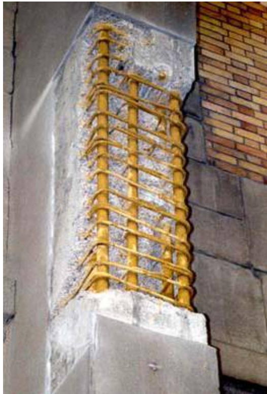
Figure 3.1 : Réfection des bétons et protection des armatures.
