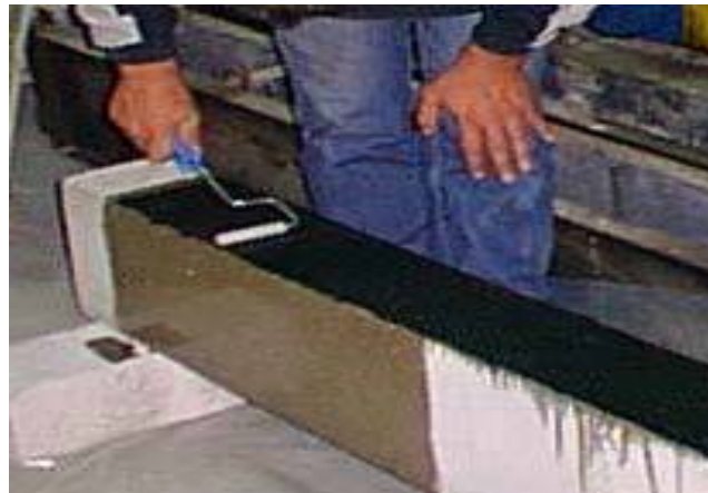
(6) Marouflage: dégagement des bulles d'air avec un rouleau
