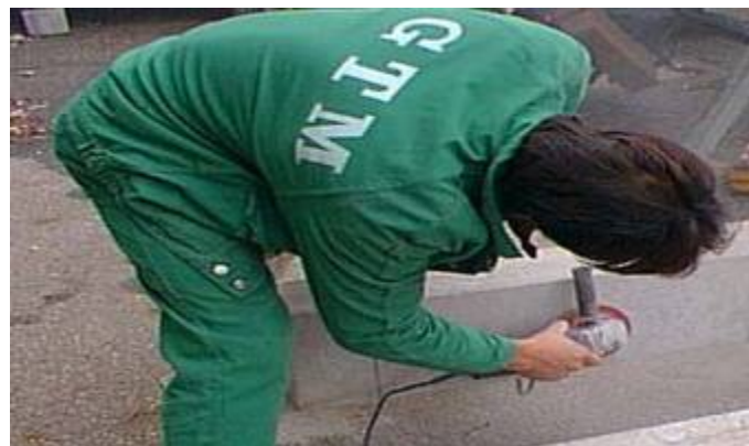
(1) Ponçage de la surface du support béton
