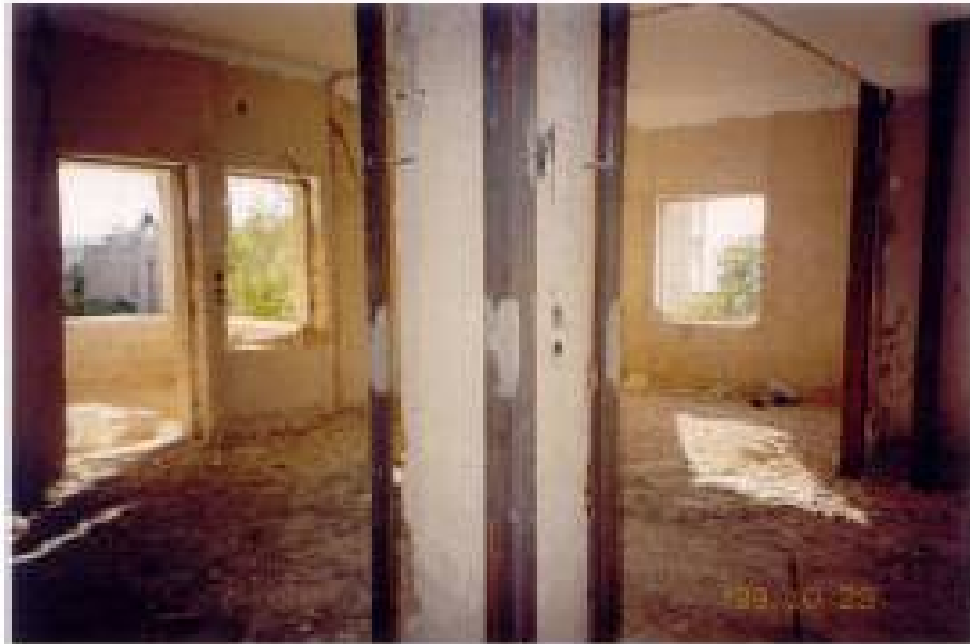
Fig3-6 Renforcement de poteaux au moyen de profilés métallique.
