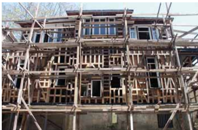
8. La consolidation de la structure de 'Sünnet Köşkü' (l'archive de Can Binan)
