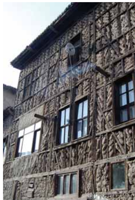
2. Une maison en pans de bois remplie par les briques en pisé à Osmaneli, Adapazarı.
