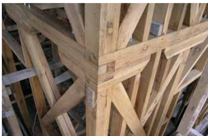
7. La consolidation des assemblages par des fers boulonnés à 'Birkökler Vakfı Konağı' (l'archive de Can Binan)
