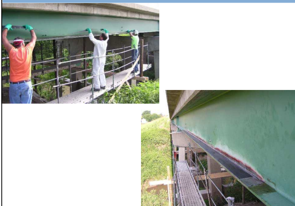
Renforcement des poutres en acier d'un pont mixte par collage de bandes de PRFC
