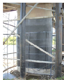
Exemple OA : Pont Lautaro (Chili), réparation après le séisme de 2010 (source AFGC/Fyfe)
