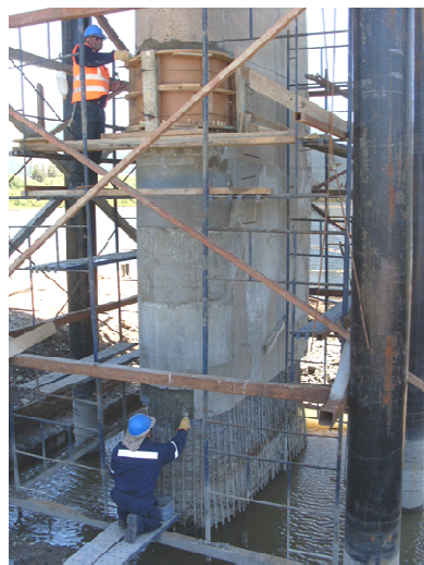
Exemple OA : Pont Lautaro (Chili), réparation après le séisme de 2010 (source AFGC/Fyfe)
