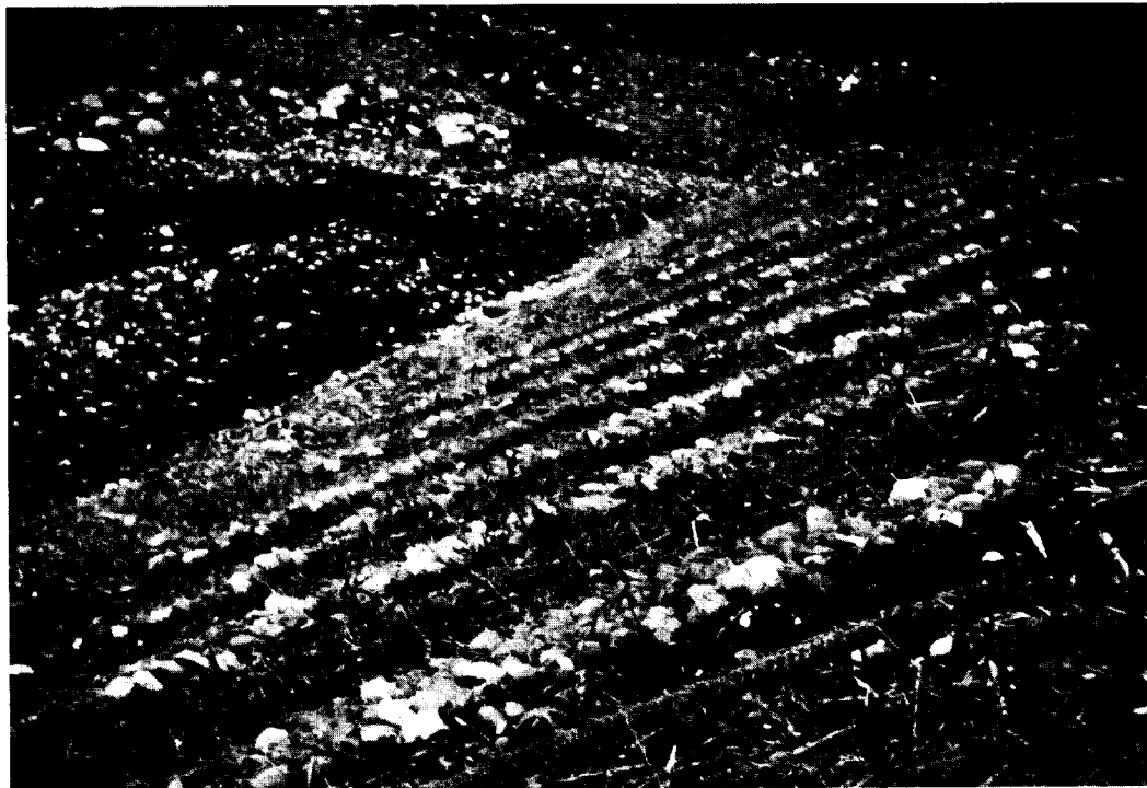
Fig. 4.6 Treillis de fil de fer avec alignements de cailloux intermittents assurent la protection de cours d'eau à fortes pentes à la Jamaïque. La croissance de la végétation est favorisée à travers le treillis, ce qui renforce la stabilité de la berge tout en réduisant localement la vitesse. Photo W.R. White, HRS, 1972. (Copyright de la Couronne, reproduit avec l'autorisation du Contrôleur HMSO et de la Station de Recherche Hydraulique, Wallingford, Royaume-Uni).
