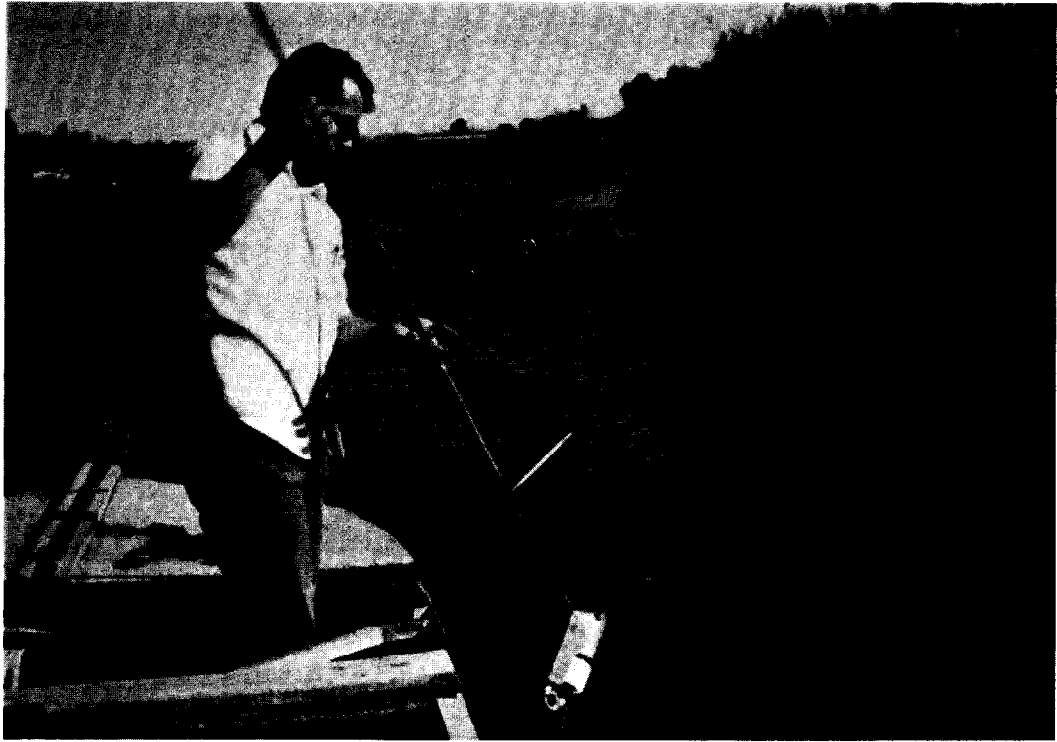
Fig. 3.8 Préleveur sur perche de matières en suspension par intégration verticale (US DH-48) utilisé depuis un petit bateau sur le Colorado, près de Yuma, Arizona, E.U. (Bureau of Reclamation, E.U., 1978).
