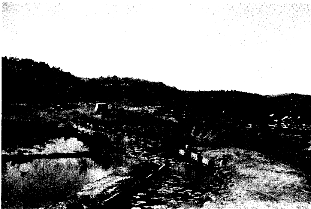
Fig. 4.8 Palissades protégeant des chenaux de drainage près du lac de Bolgoda, Sri Lanka. Photo P. Waite, HRS, 1978. (Copyright de la Couronne, reproduit avec l'autorisation du Contrôleur HMSO et de la Station de Recherche Hydraulique, Wallingford, Royaume-Uni).
