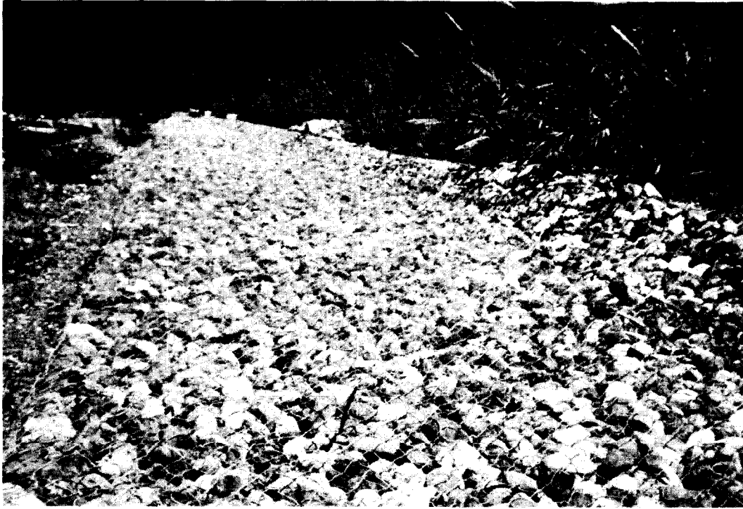
Fig. 4.9 Matelas de gablons protégeant la base des berges le long de la rivière Yallahs, Jamaïque. Photo W.R. White, HRS, 1972. (Copyright de la Couronne, reproduit avec l'autorisation du Contrôleur HMSO et de la Station de Recherche Hydraulique, Wallingford, Royaume-Uni).
