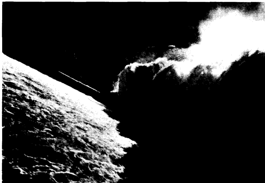
Fig. 5.16 Déversoir d'El Chocon. D'après El Chocon Dam. Field observations of the performance of the spillway (HRS INT 124) , par W.R. White et E. Whitehead, 1974 (Copyright de la Couronne, reproduit avec l'autorisation du Contrôleur HMSO et de la Station de Recherche Hydraulique, Wallingford, Royaume-Uni).
