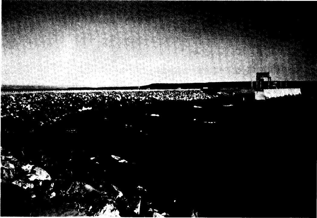
Fig. 4.7 Des rochers à l'état brut protègent contre les vagues le parement amont du barrage d'El Chocon, Argentine. Photo W.R. White, HRD, 1973. (Copyright de la Couronne, reproduit avec l'autorisation du Contrôleur HMSO et de la Station de Recherche Hydraulique, Wallingford, Royaume-Uni).
