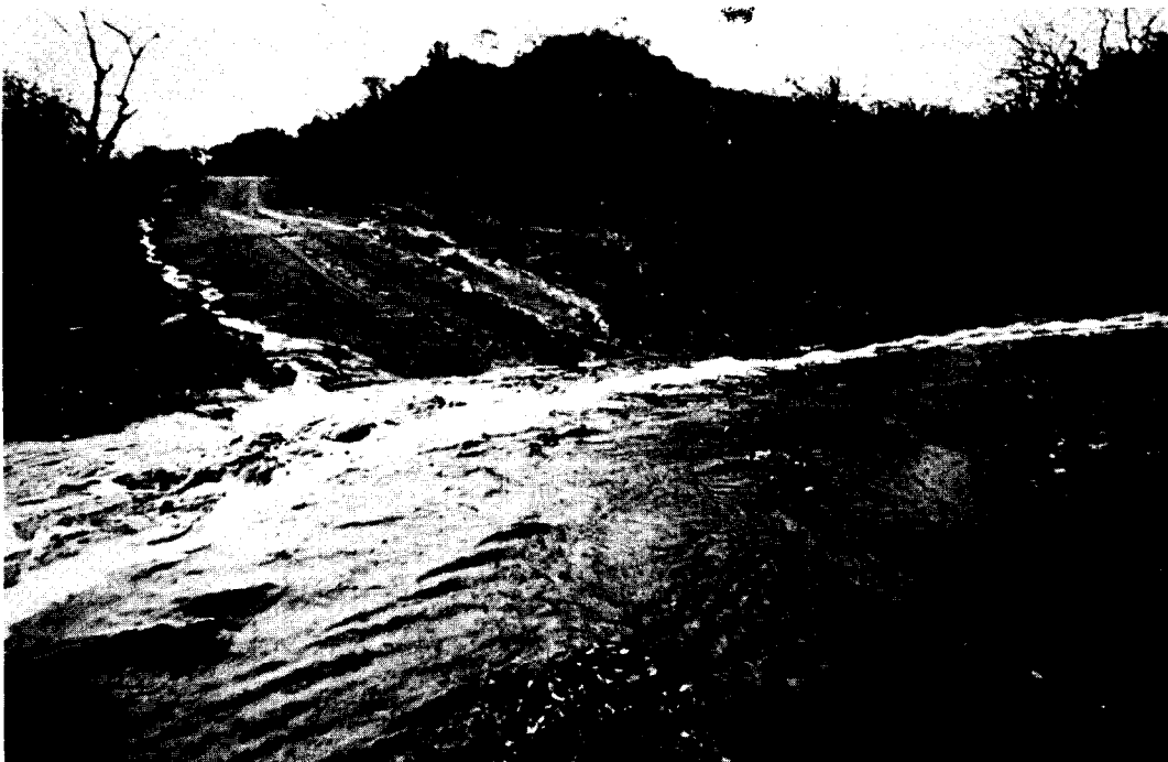
Fig. 1.7 Ruissellement rapide et concentré érodant et dévastant la route entre Iringa et Mawanda (Tanzanie Centrale). Photo L. Stromquist, 1976
